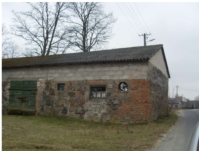
Fot. M. Stankiewicz, Budynki gospodarcze pokryte płytami z eternitu
