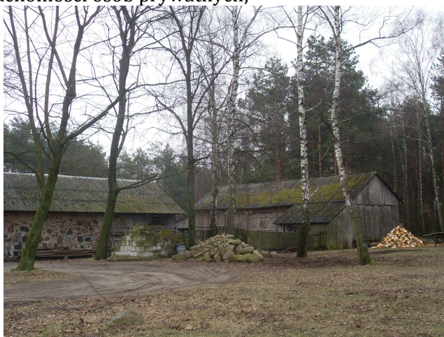
Fot. M. Stankiewicz, Budynki gospodarcze pokryte płytami z eternitu
