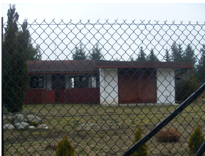
Fot. M. Stankiewicz, Budynki rekreacyjne pokryte płytami z eternitu
