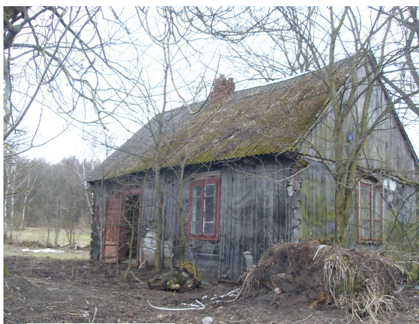
Fot. M. Stankiewicz, Uszkodzone płyty eternitowe
